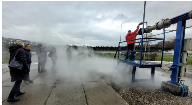
Bańska PGP-1 well / PEC Geotermia Podhalańska S.A.
